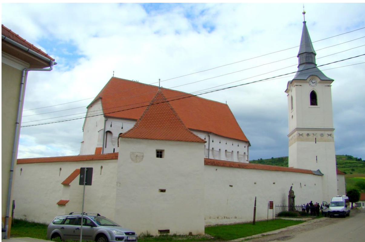
Figura nr. 2: Ansamblul bisericii fortificate din Dârjiu – se vede biserica fortificată, o parte din zidul de apărare, turnul de apărare din partea sud-vestică și clopotnița
